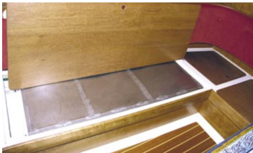
Die Niro-Wassertanks liegen unter den Salonkojen
