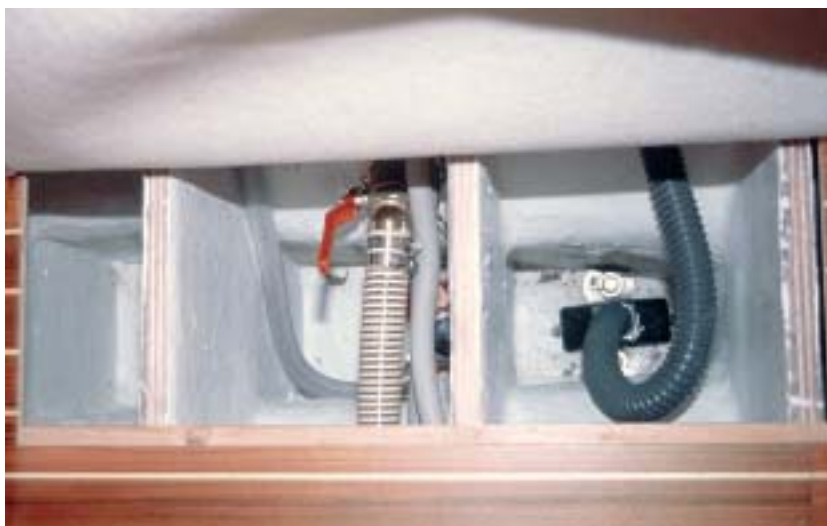
Ein Blick in den tief reichenden Bilgensumpf mit der stabilen Bodenkonstruktion durch die weit nach unten gezogenen Bodenwrangen
