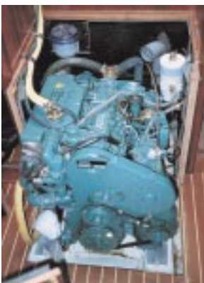
Um an die Maschine gelangen zu können, muß man den ganzen Niedergang demontieren.
