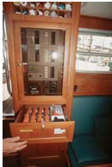
Die Seenotsignale sind in Schubfächern unter der Schalttafel untergebracht
